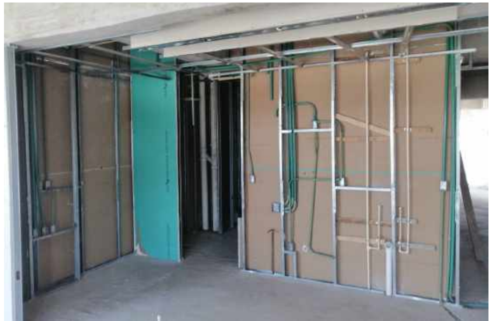
Inst. Eléctricas en Muro Nivel 08
