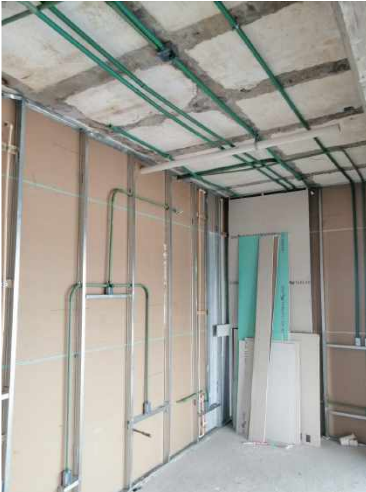
Inst. Eléctricas en Muro Nivel 14
