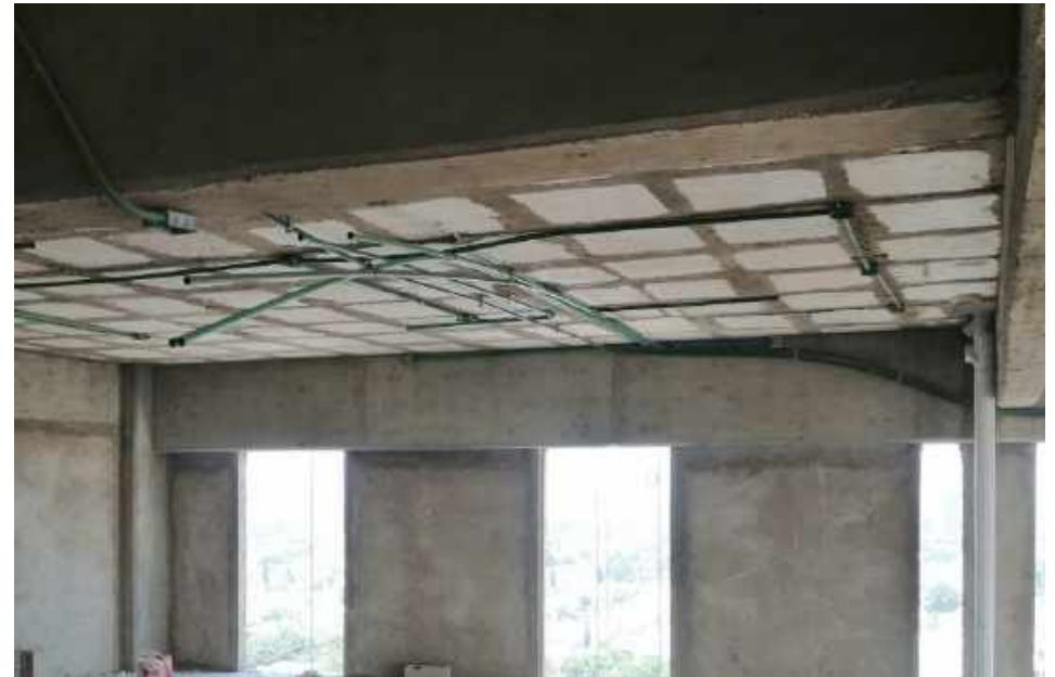
Inst. Eléctricas en Losa Nivel 21
