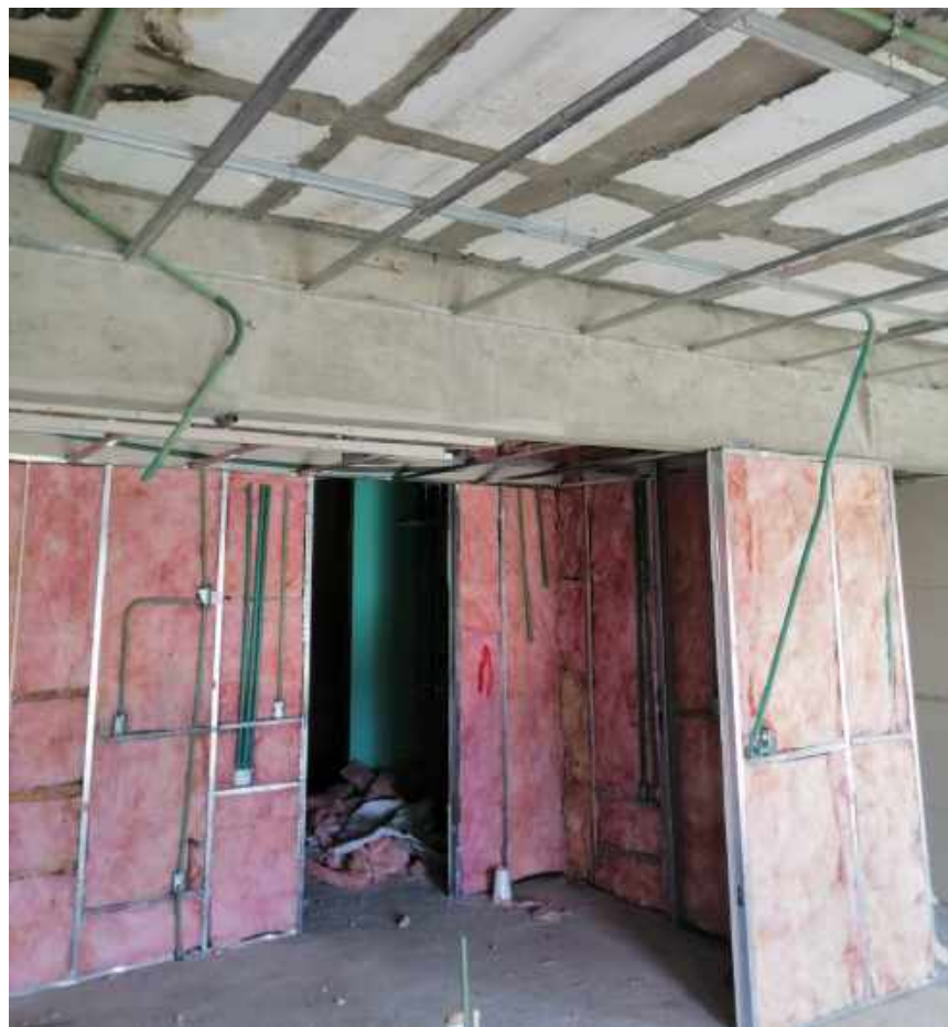
Muro de Tablaroca Nivel 6
